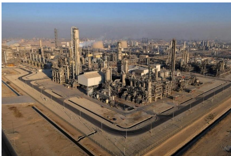
Рис. 5. Химический комплекс Sadara в составе Jubail Industrial City II, Джубайль, Саудовская Аравия. Полная коммерческая эксплуатация комплекса с 2017 г.
